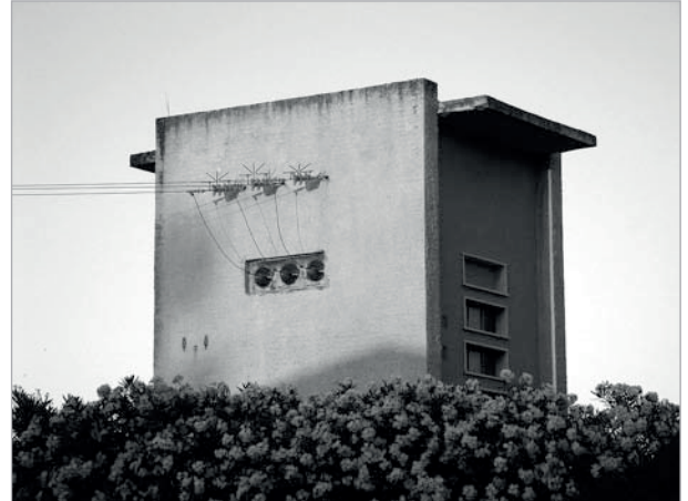
„Trafostation“, Peter Matthys
